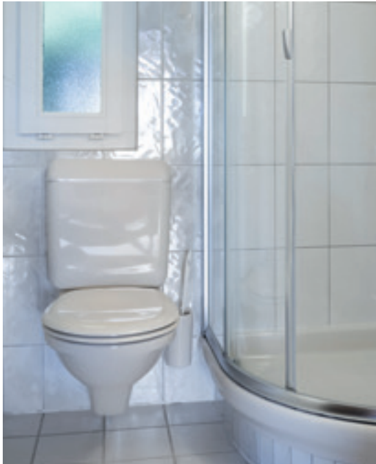
VORHER Einbausituation mit Aufputzspülkasten
