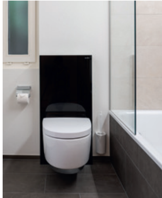
NACHHER Einbausituation mit Geberit Monolith
